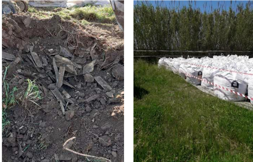
Figura 3. Bonifica microdiscariche diffuse (Rimozione di circa 700 tonnellate di amianto)
