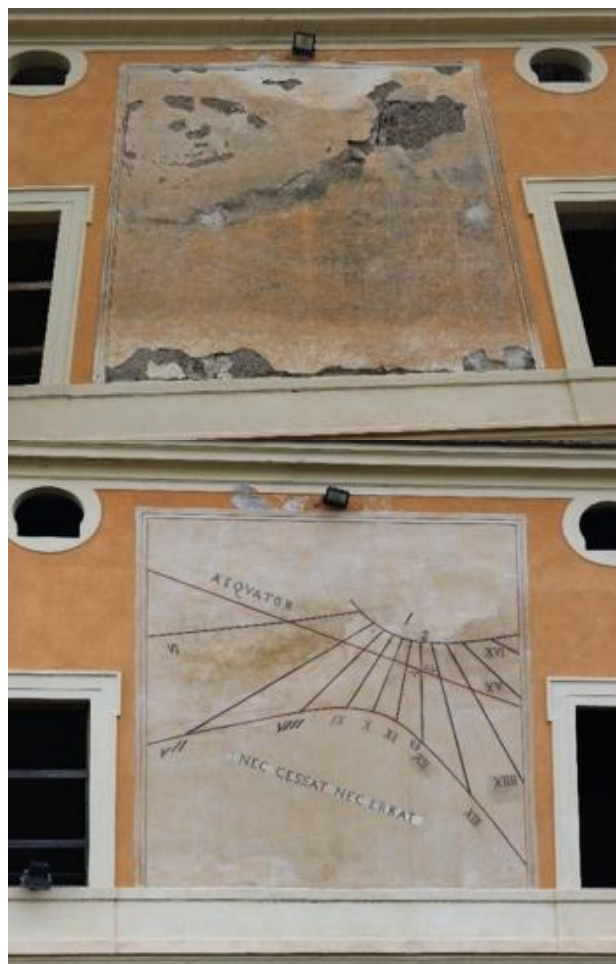
Figura 4. Restauro delle Meridiane Fonte: Fondazione Real Sito di Carditello
